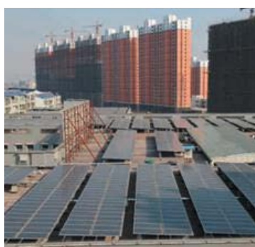
镇江新区逸翠园邻里菜场屋顶
